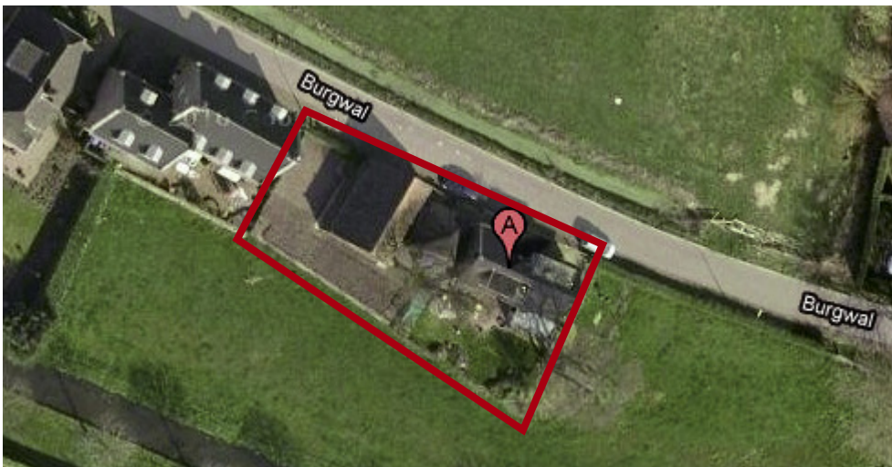
afbeelding 4, detail uit de luchtfoto van 2007 met het onderzoeksgebied (rood omlijnd).
